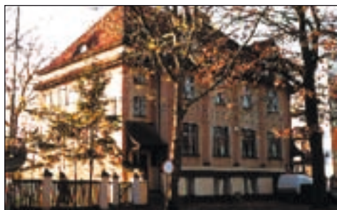
Siedziba Powiatowego Urzędu Pracy
