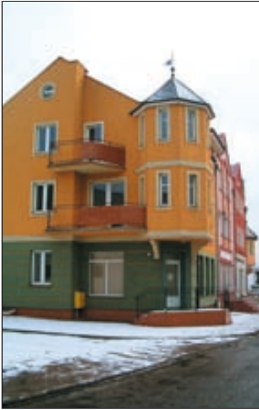
Stare Miasto - współczesne budownictwo przy ul. Południowej
