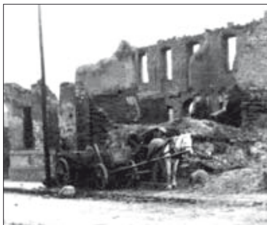
Rozbiórka gotyckiego szpitala św. Gertrudy - lata 40. XX w.
