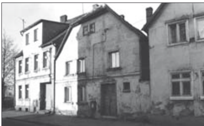
Kamieniczki z przełomu XIX/XX w. przy ul. Południowej
