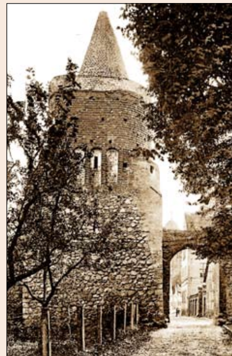
Baszta Więzienna, widok od strony północnej (zewnątrznej), lata 20. XX wieku
