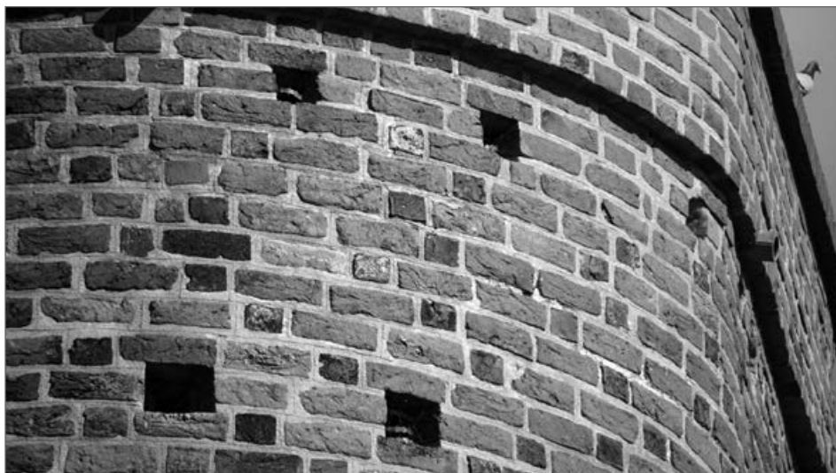
1. Fragment zachodniej elewacji Baszty Więziennej, fot. A. Duda, 2020
