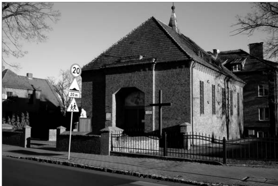
6. Kościół pw. św. Franciszka z Asyżu w Strzelcach, widok od strony południowo-zachodniej, fot. B. Skaziński, 2020
