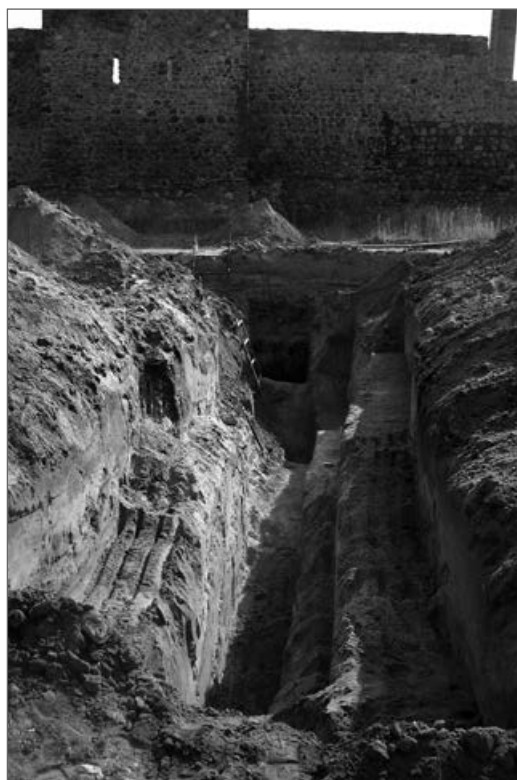
6. Przebieg prac, fot. P. Kaźmierczak, 2006
