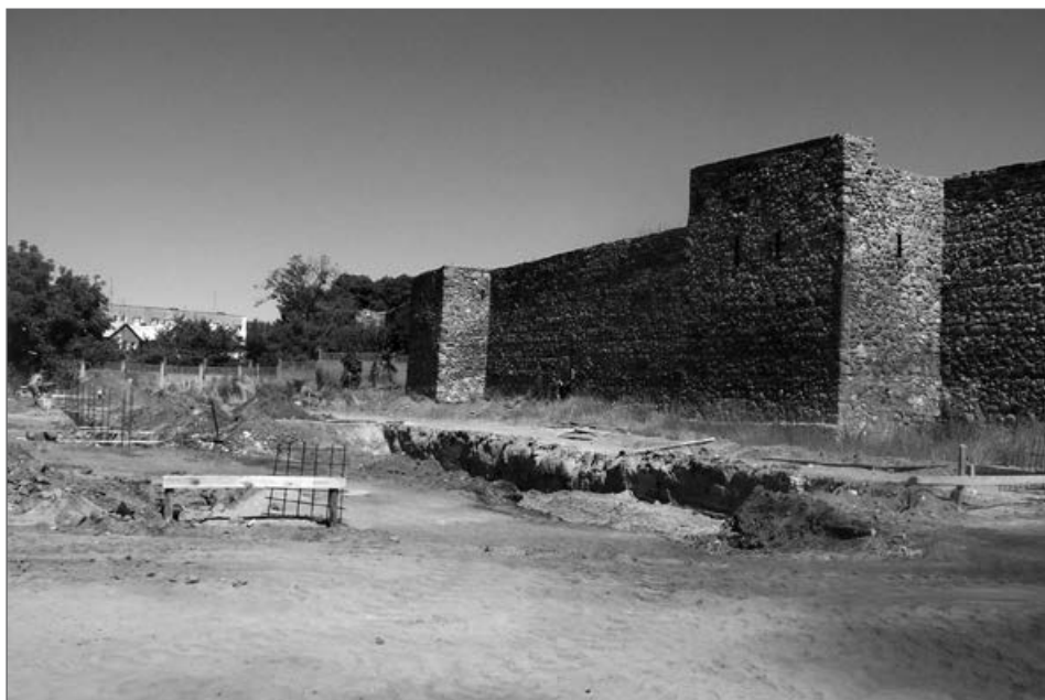
5. Przebieg prac, fot. P. Kaźmierczak, 2006
