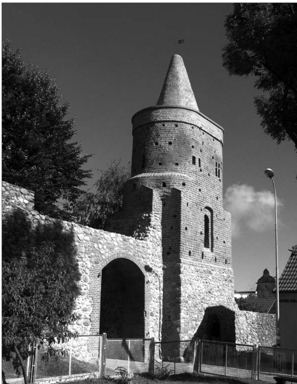
11. Baszta Więzienna w Strzelcach, widok od strony południowo-zachodniej, fot. M. Bidol, 2018
