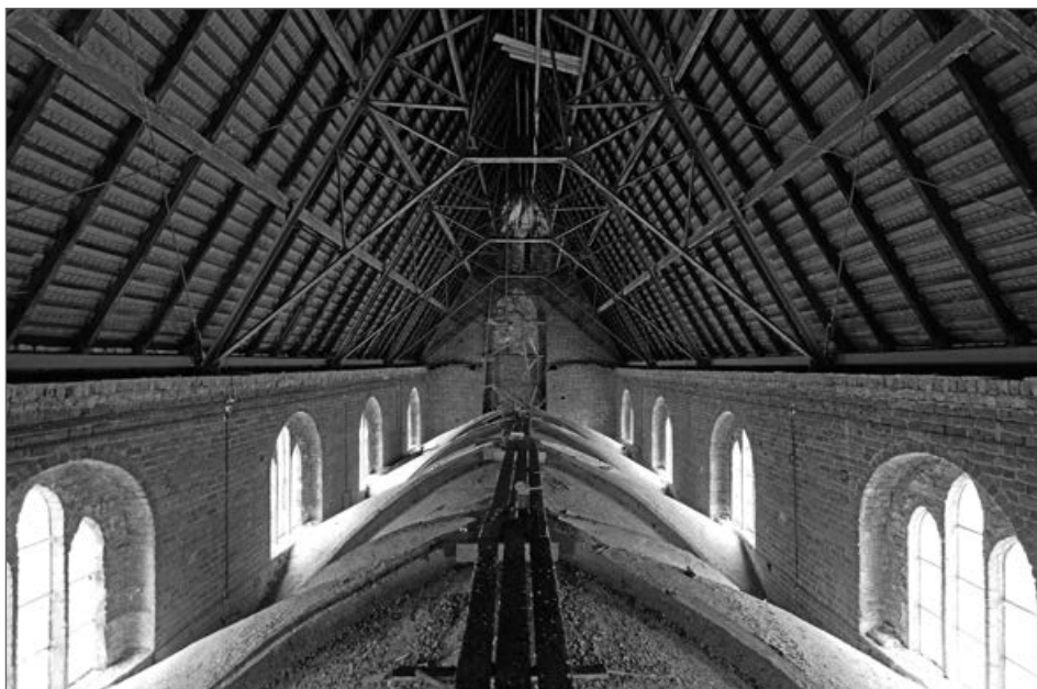
20. Kościół Mariacki w Strzelcach Krajeńskich, widok konstrukcji dachowej nad nawą główną w kierunku wschodnim, fot. M. Fiedorowicz, 2020
