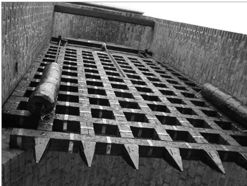
11. Brama Młyńska w Strzelcach, zrekonstruowana brona osadzona w dawnej prowadnicy, fot. M. Bidol, 2018
