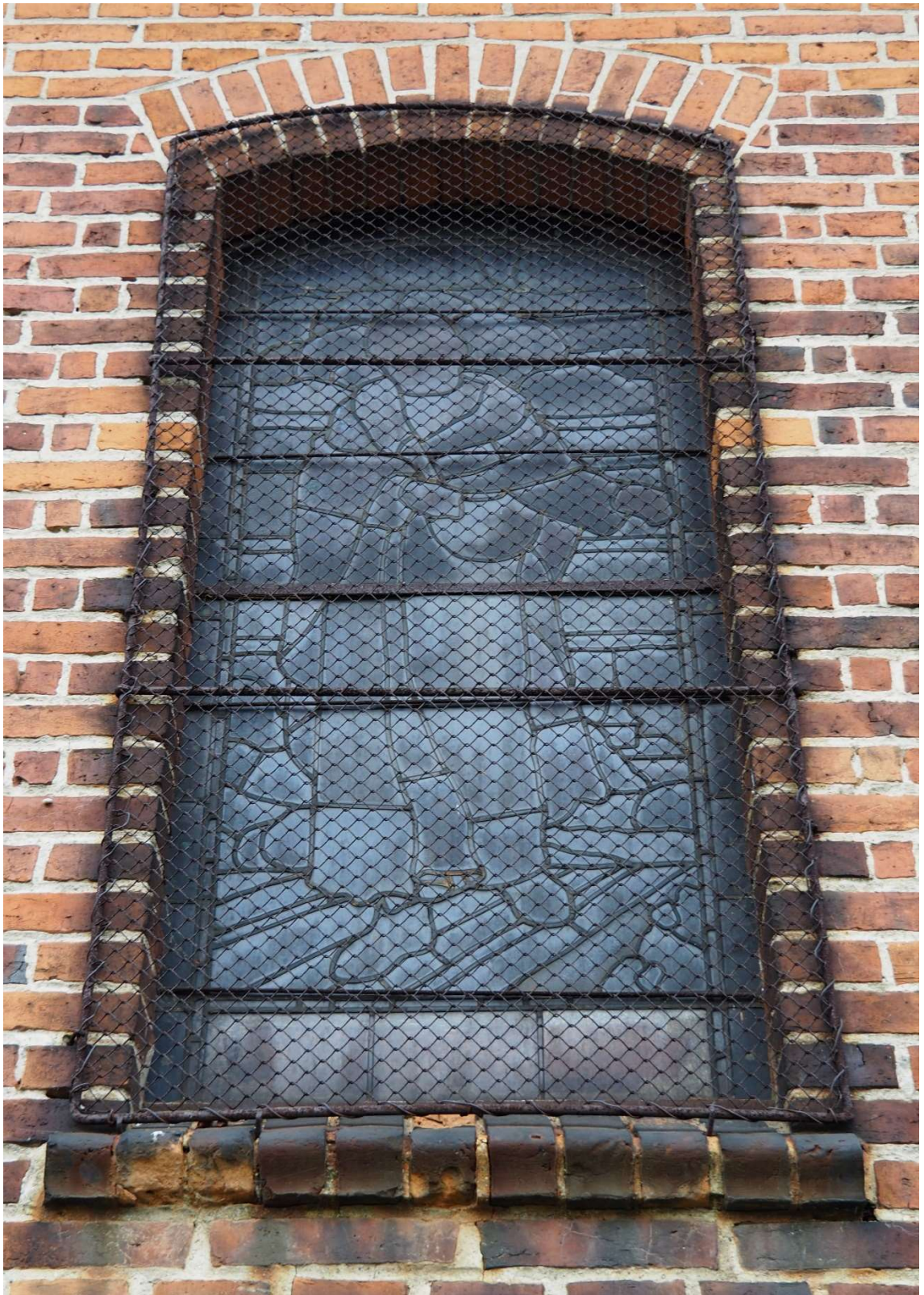
Widok okna 5 s, str. południowa
