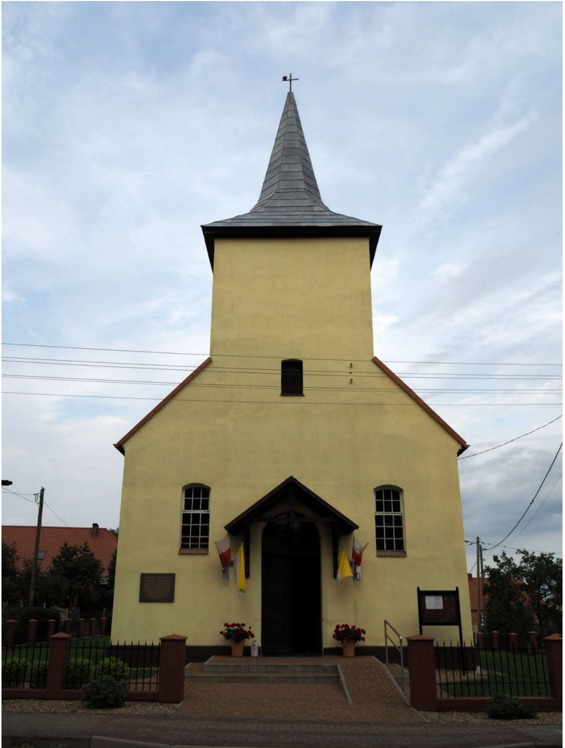
Elewacja str. zachodnia
