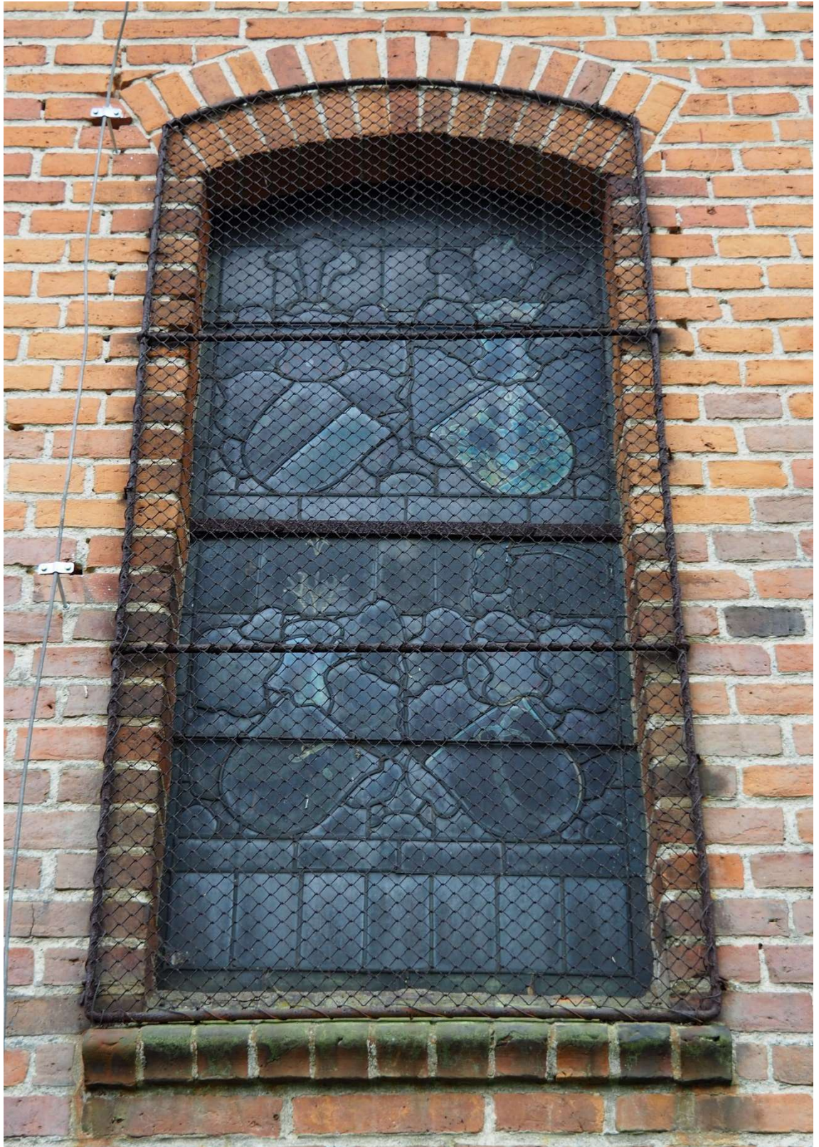
Widok okna 3 n, str. północna
