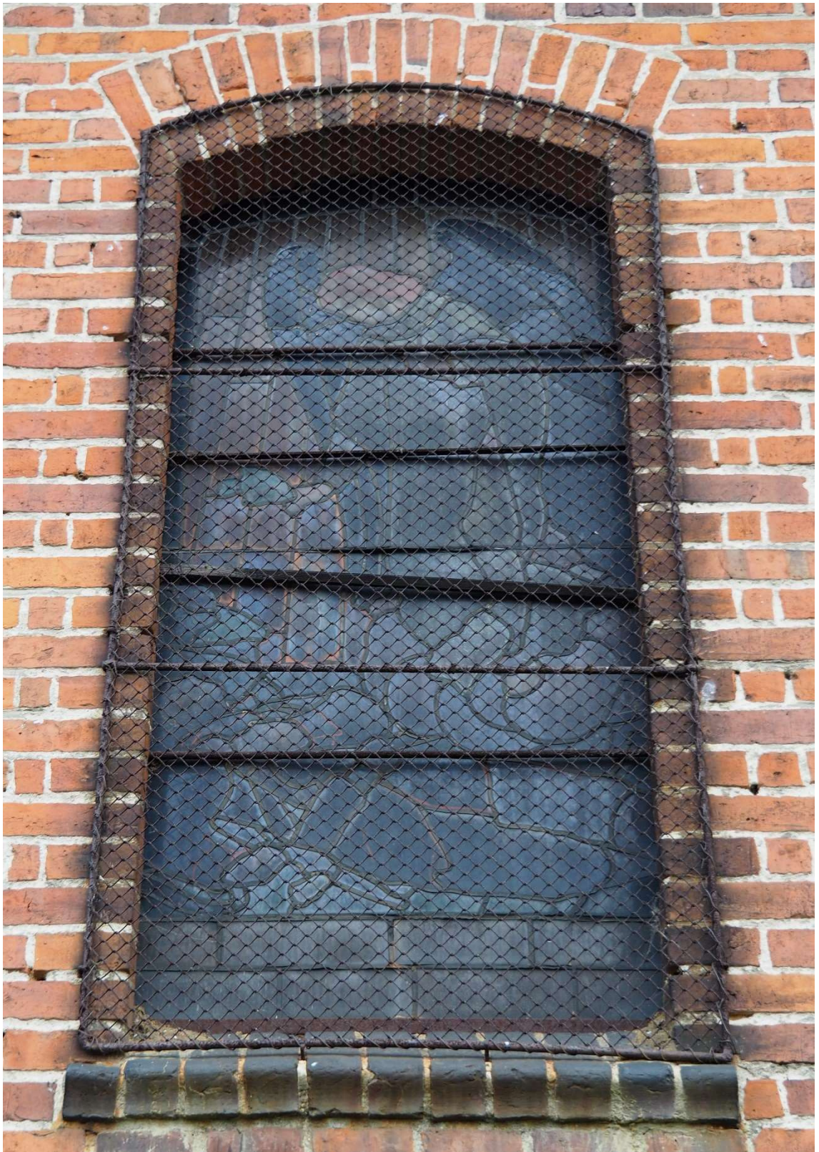
Widok okna 7 n, str. wschodnia
