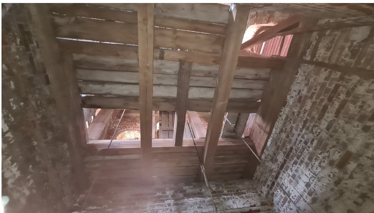
Fot.23. strop drewniany w poziomie +15,80.
