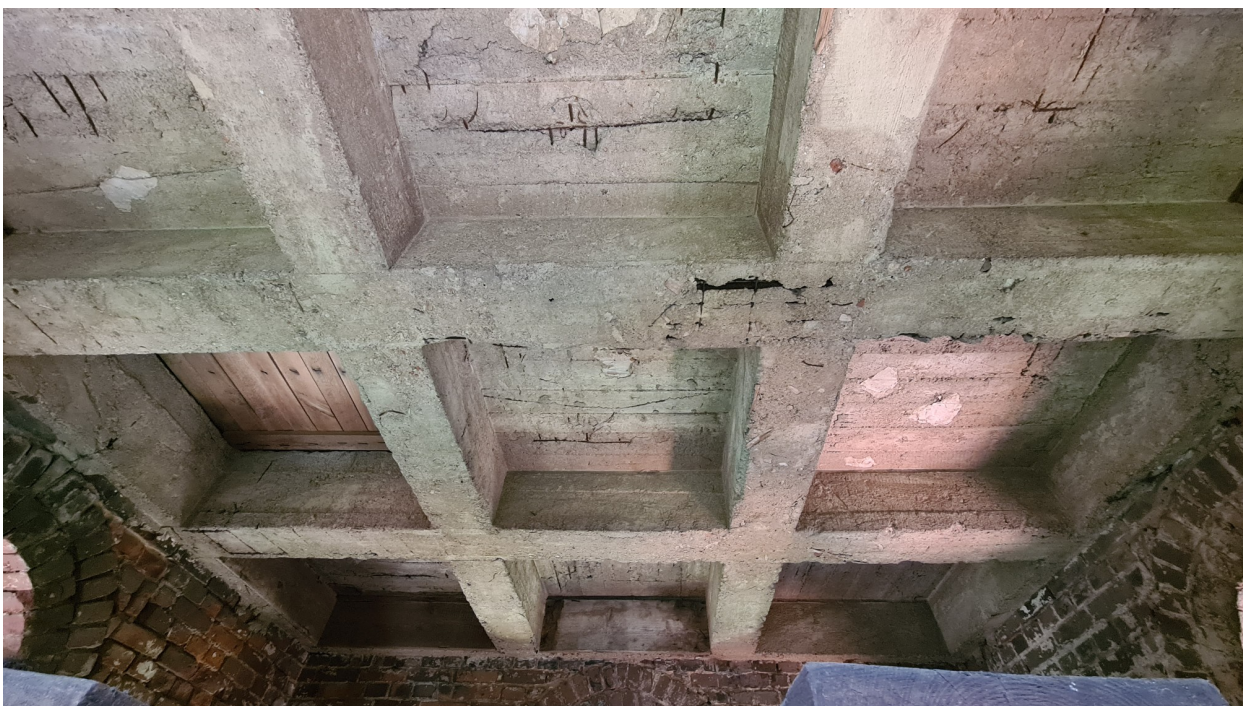
Fot.24. Strop żelbetowy w poziomie +19,30.
