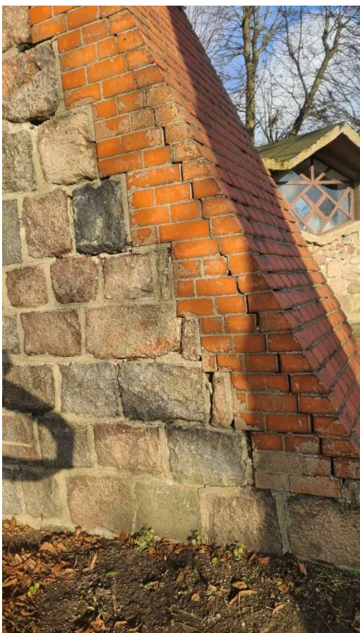
Fot.12. Widok uszkodzeń przypory w wschodnim narożniku.
