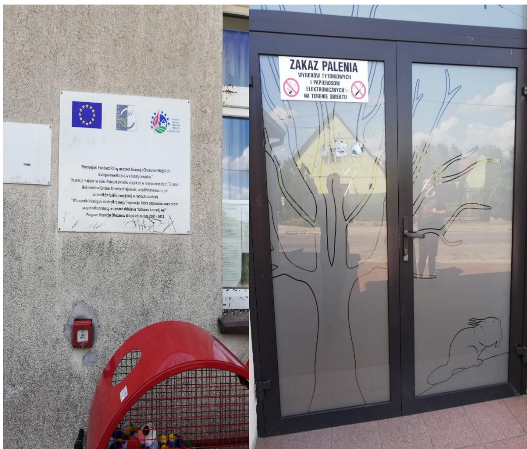
Zdjęcie 10. Fasada i wejście do świetlicy wiejskiej w Bobrówku
