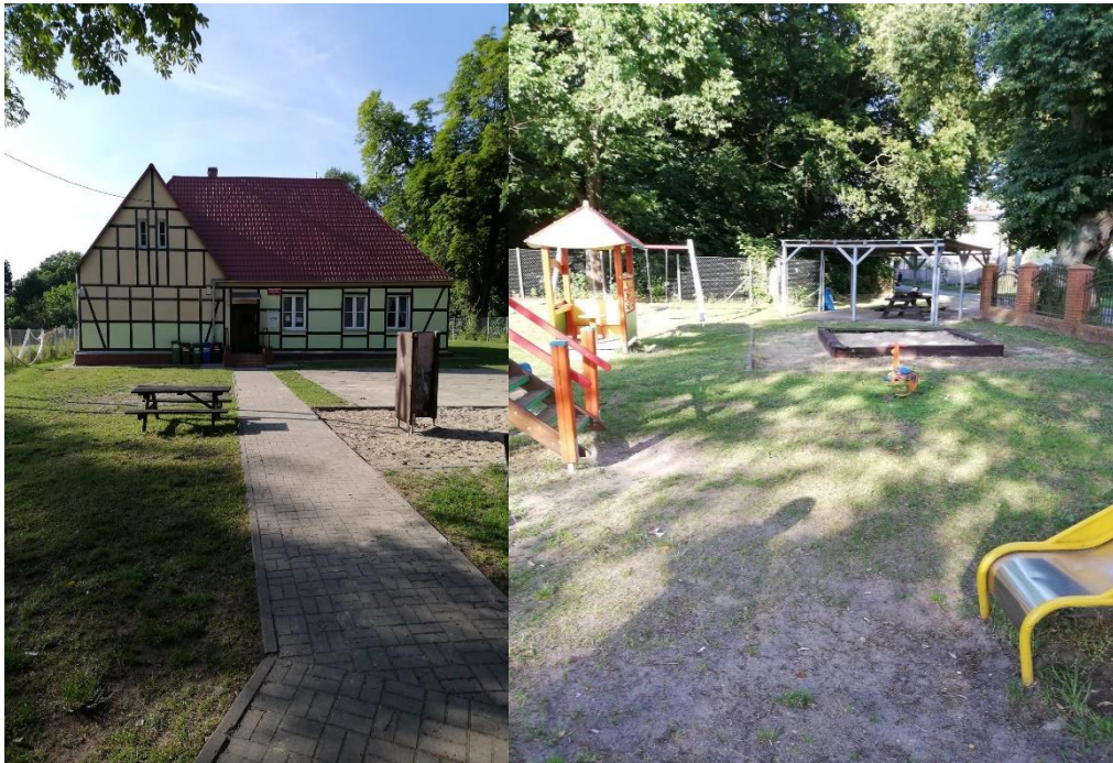
Zdjęcie 14. Piękne otoczenie budynku świetlicy i biblioteki w Tucznie.
