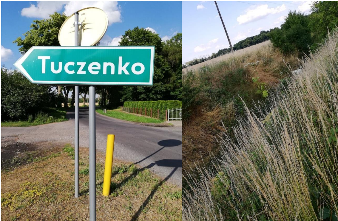
Zdjęcie 5. Zarośnięty rów melioracyjny między Tucznem a Tuczenkiem
